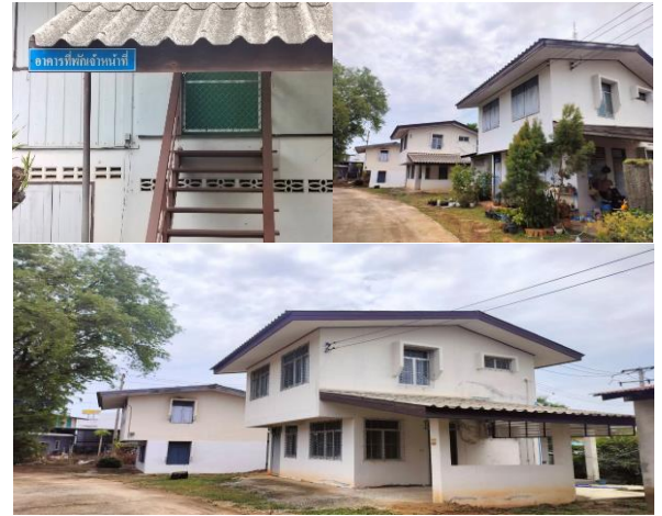
อาคารบ้านพัก
